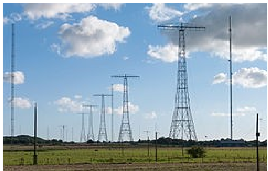
Masterna vid radiostationen i Grimeton
